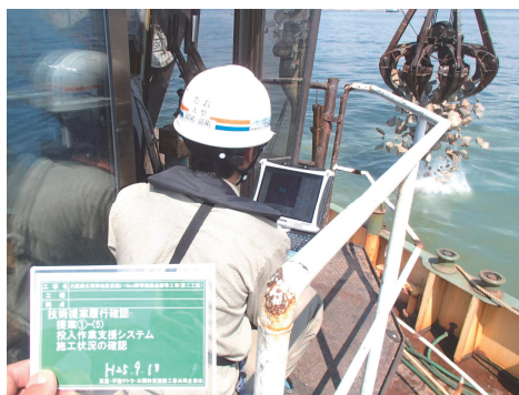
写真-1 捨石投入状況
