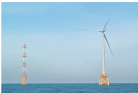
写真-1 風力発電施設の設置状況
