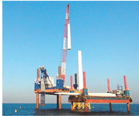
写真-4 SEP 船を活用した洋上での風車組立
