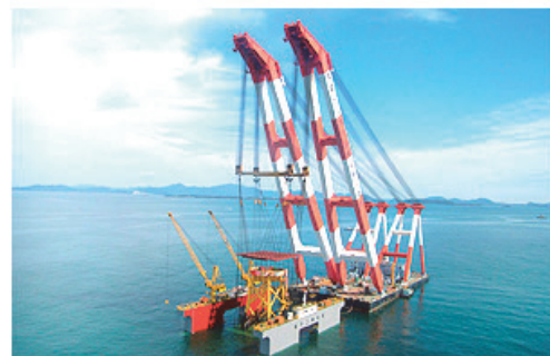
写真-3 大型起重機船による支持構造物の据付
