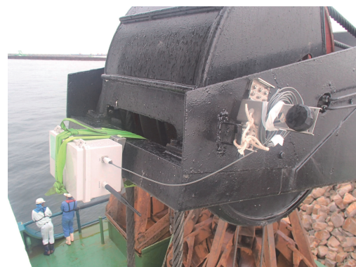
写真-2 機器設置状況 (ガット船ブーム先端)
