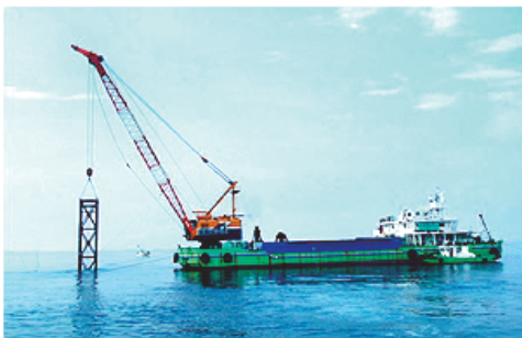
写真-2 重錘落下による機械式での均し作業
