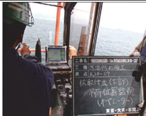
写真-2 吊荷位置監視状況
