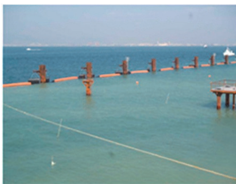
写真-4 汚濁防止膜設置完了
