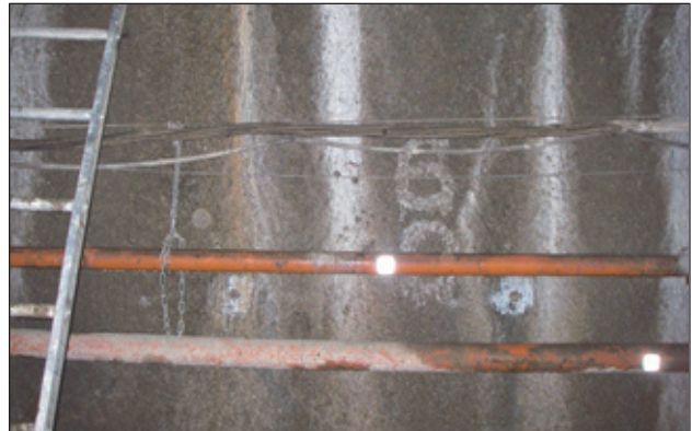
写真-2 画像合成・測量用 反射ターゲット
