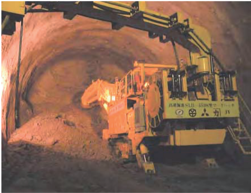
写真-1 高速掘進工法での掘削状況
