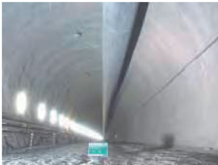
写真-3 掘削吹付け仕上がり状況
