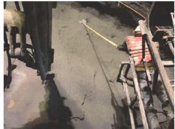
写真-2 再帰性反射塗料の塗布状況（ローラ式）
