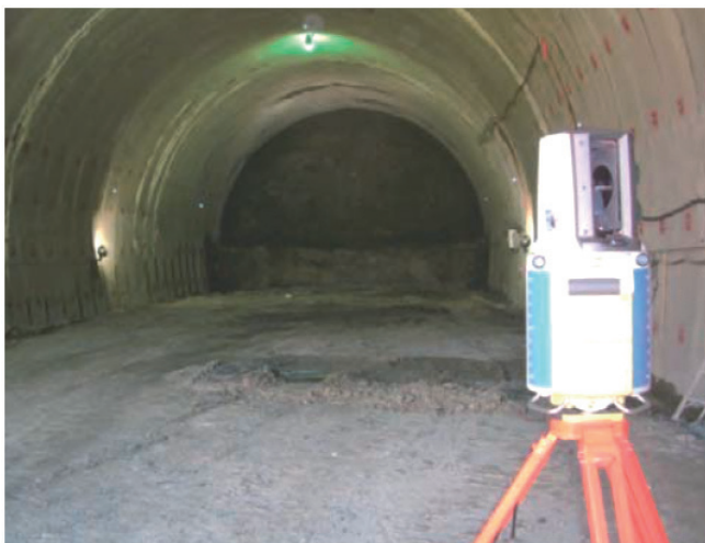
写真-1 3D スキャナによる計測状況
