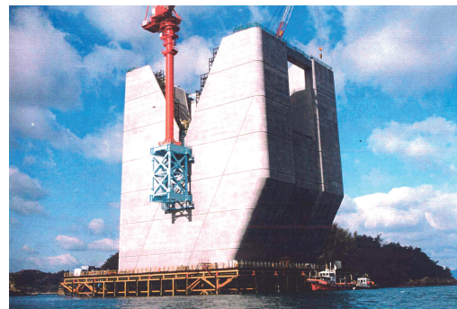
写真-1 来島大橋 4A アンカレイジの全景
