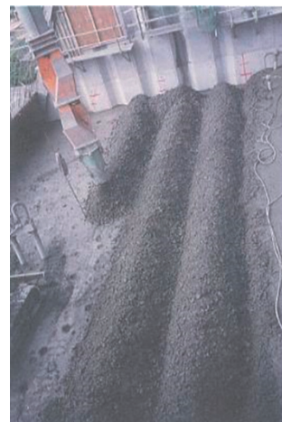
写真-2 自動運転施工状況
