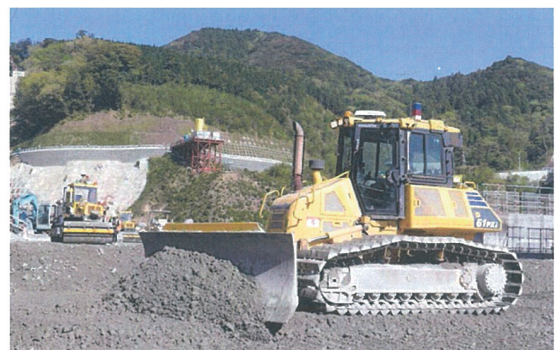
図-2 五ヶ山ダムでの実施状況 (自動ブルドーザと自動振動ローラ)
