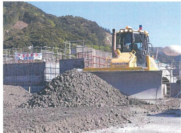
図-6 自動ブルドーザによる RCD コンクリート撒き出し作業状況
