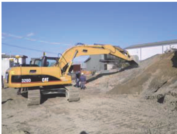
図-5 マシンガイダンスによる法面整形状況
