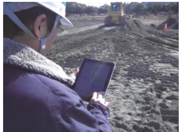
図-5 iPadによる施工管理
