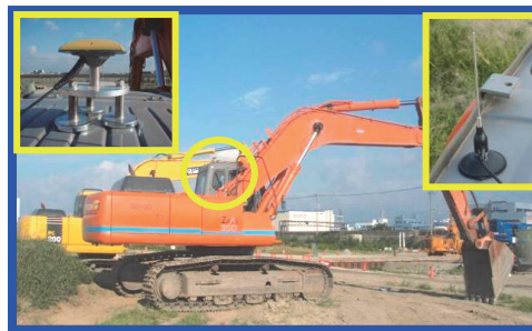
写真-3 掘削機械に搭載した GPS 基準局
