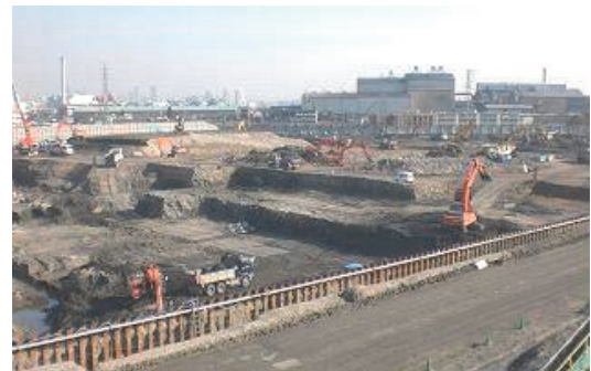
写真-1 掘削状況
