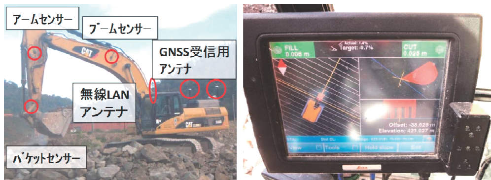
図-6 RTK-GNSS を用いたバックホウの施工指示
