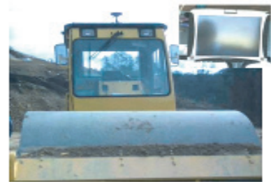
写真-3 振動ローラ頂部に設置 GPS 受信アンテナと運転席の PC モニタ
