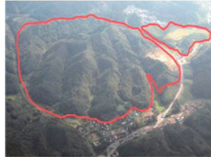
写真-2 工場掘削前全景
