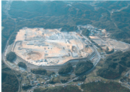
写真-1 工場掘削後全景
