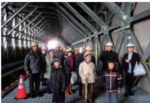
高岡除雪基地雪覆他工事見学会
