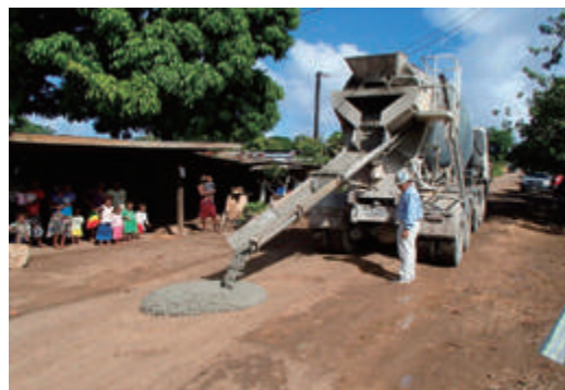
作業所周辺道路の補修（海外）
