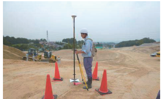
図-3 VRS-GNSSによる基準点測量
