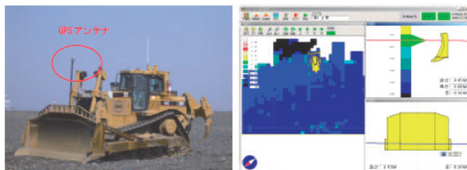
図-3 ブルドーザ造成支援システム
