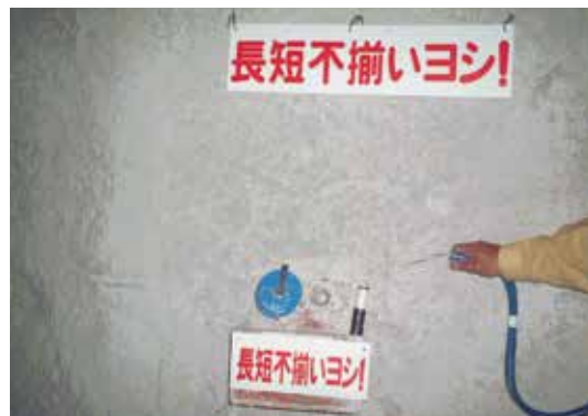
発破母線の末端処理方法の掲示(切羽側)の例
