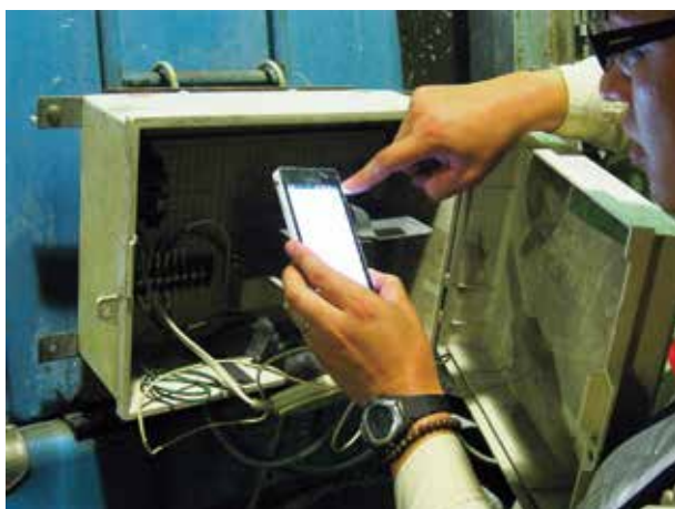
スマートフォンによる発破合図の例 （坑内退避場所）
