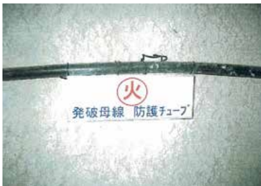
発破母線の防護の例
