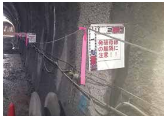
発破母線と電線との離隔確保の例
