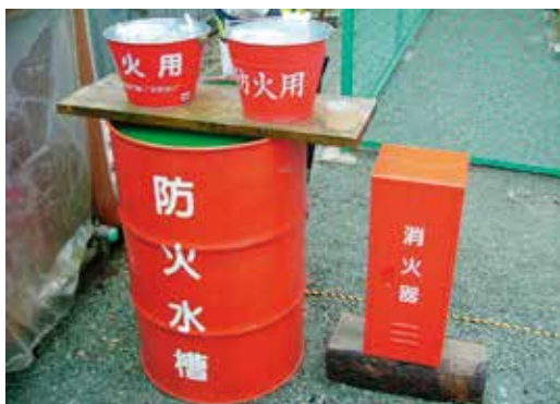
防火用水の設置と消火品、スコップの保管の例
