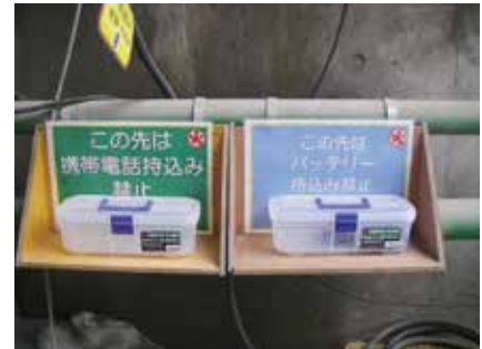
携帯電話、バッテリー収納箱の例
