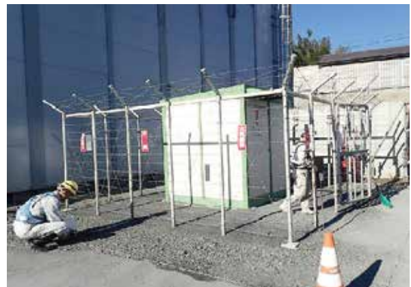
トラロープによる明示の例
