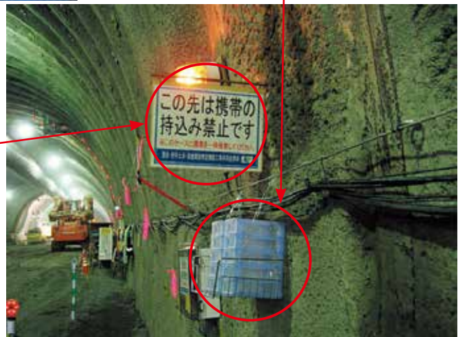
注意喚起標識の例、携帯電話一時保管場所の例
