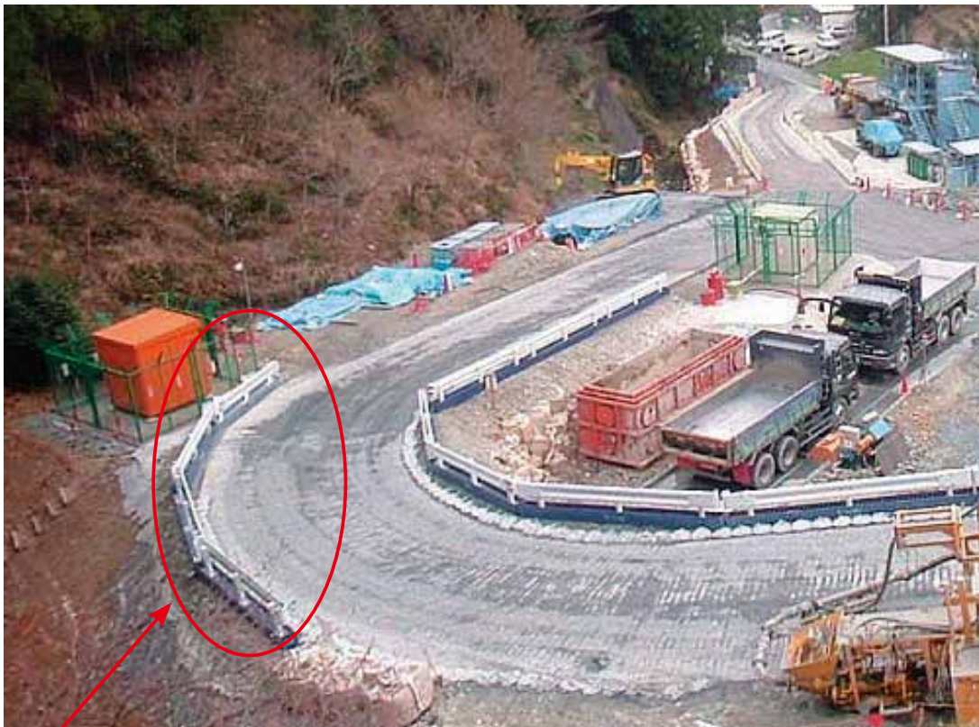
急勾配の曲線道路沿いの取扱所、火工所に設置されたガードレールの例
