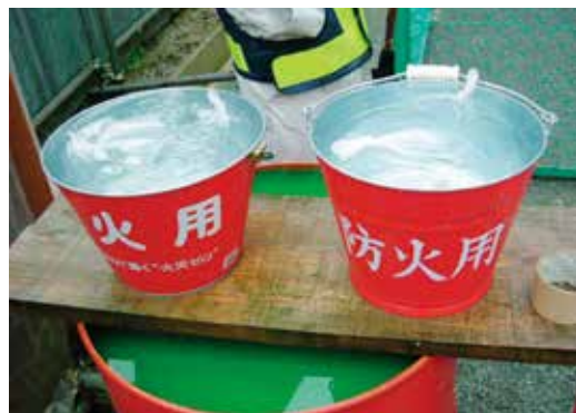
防火用水の設置と消火品、スコップの保管の例
