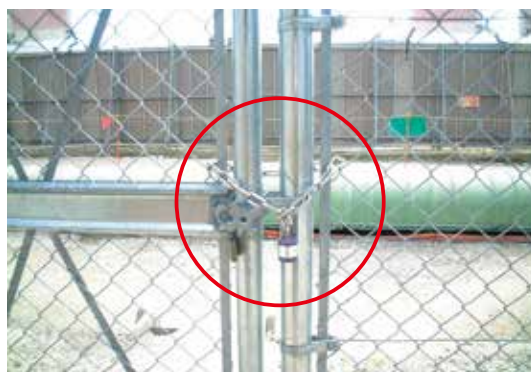
外柵扉内側からの施錠の例
