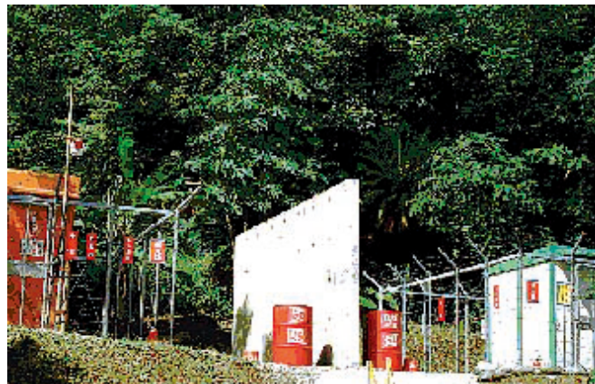
鉄筋コンクリート造の例 (現場打ちコンクリート 厚 15cm 以上)
