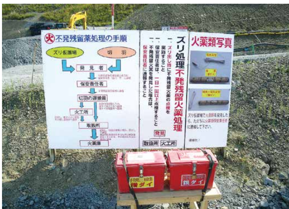
不発残留薬回収フロー掲示の例
