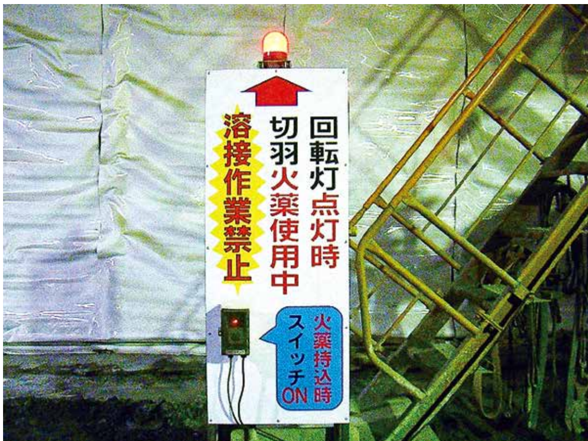
溶接作業禁止のパトライト表示（セントル付近）の例
