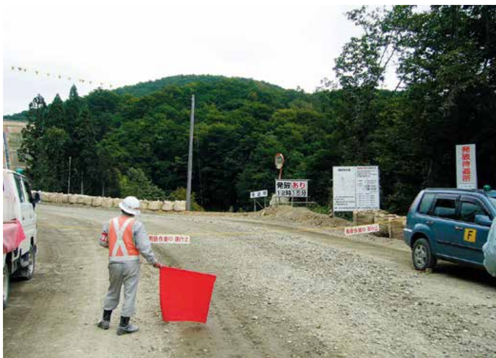
明り発破工事での警戒員配置の例
