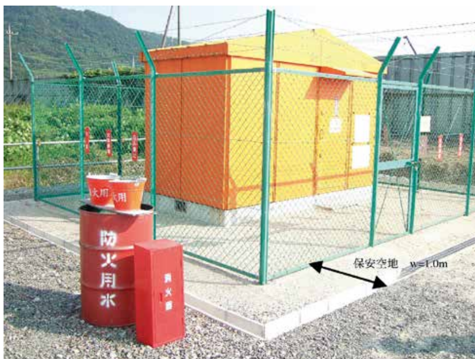
取扱所外柵の周囲に設けられた排水側溝の例
