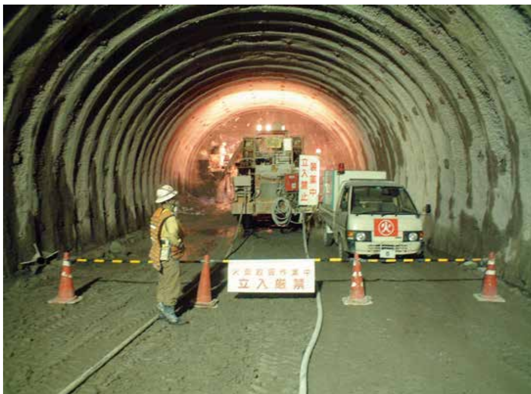
標識、バリケード設置の例、警戒員配置の例
