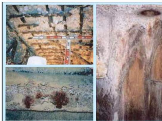
写真-1 下水道施設の腐食劣化事例
