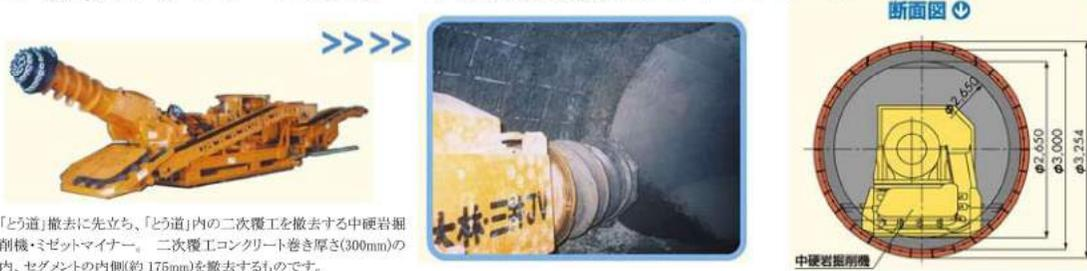
「とう道」撤去に先立ち、「とう道」内の二次覆工を撤去する中硬岩掘削機・ミゼットマイナー。二次覆工コンクリート巻き厚(300mm)の内、セグメントの内側(約 175mm)を撤去するものです。
