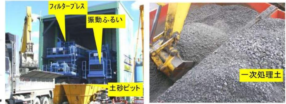
写真-1 発進基地分級処理設備と一次処理土(建設発生土) 建設汚泥の発生抑制(約 5200m3)
