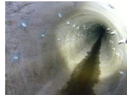
モールボルティング工法によるロックボルト補強事例
