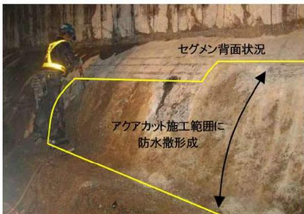
適用例：某鉄道シールドトンネル試験注入 12㎡
