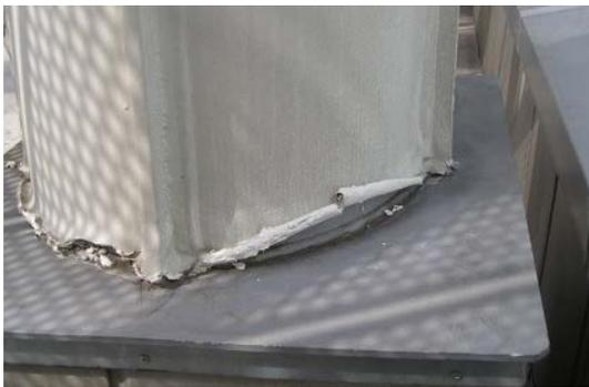
柱脚の耐火塗料の剥離
