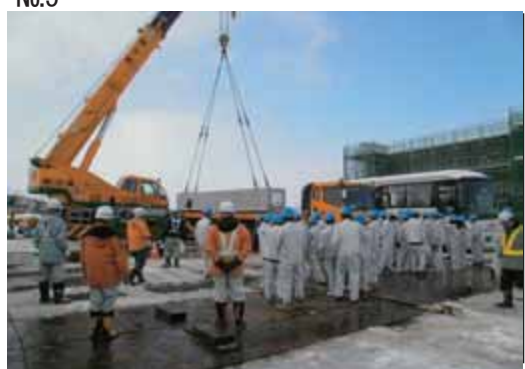
橋梁現場見学会
