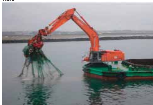
震災影響による魚網流出撤去作業
