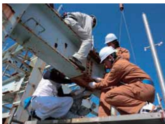
鉄骨組立解体実習
