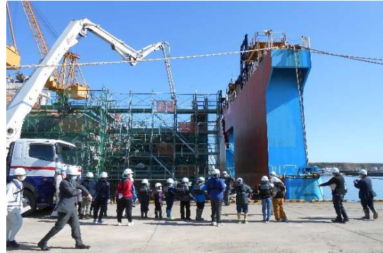
花咲港小学校全生徒を招き現場見学会
