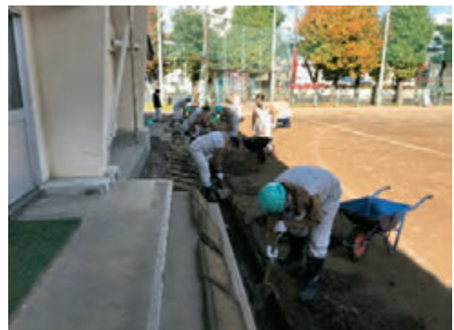
グラウンドの側溝清掃
