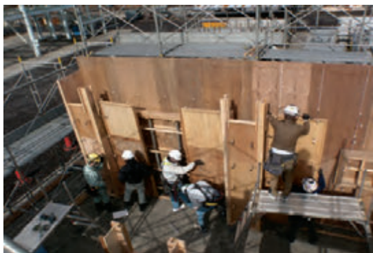
型枠組立実習
