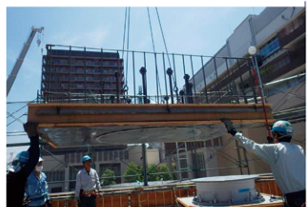
免震上部基礎 PCa 設置状況
