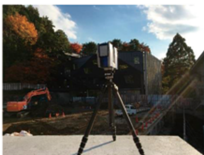
写真-1 3D スキャナー計測状況
