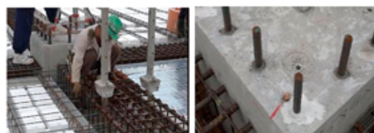
梁支保工の先行設置
