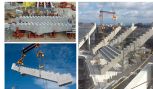
上部スタンド躯体の超大型地組プレキャスト梁
