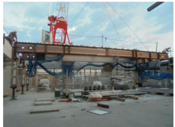
ユニット取付状況
