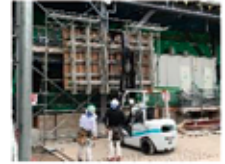
型枠試験施工
