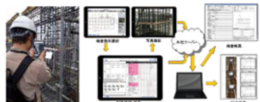
iPadによる配筋検査
