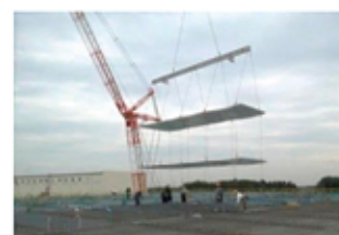
デッキプレート専用吊治具
