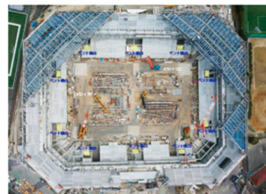
屋根トラス鉄骨の大型地組
