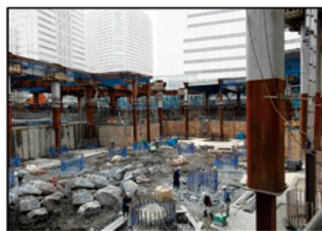
実際の施工状況 （0柱と仮設柱の併用）
