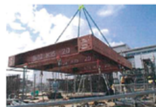
免震上部PC地組吊治具
