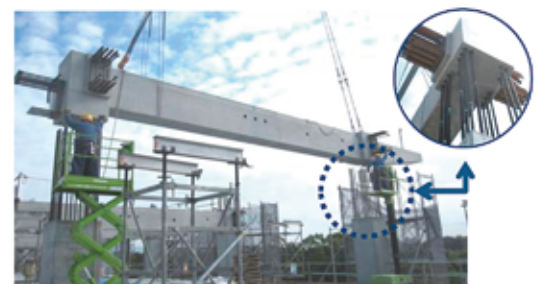
地上コンコース躯体の仕口一体型プレキャスト大梁
