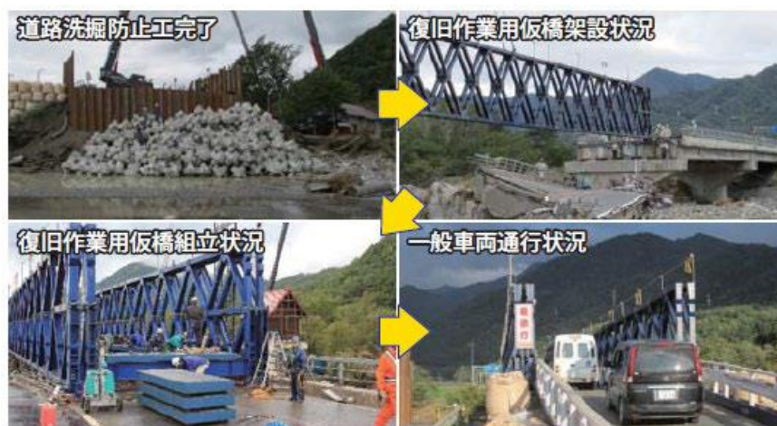
写真 2-3 迂回路等の早期解消（千呂露橋作業用仮橋）
