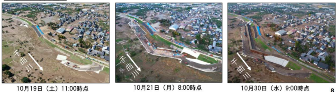
図 2-8 鋼矢板仮締切堤防の進捗状況 (提供：北陸地方整備局)
