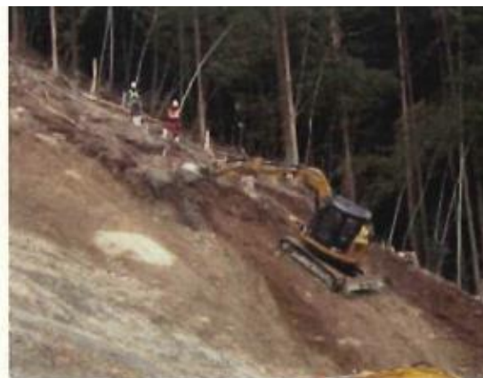
写真 3-3 セフティークライマー工法
