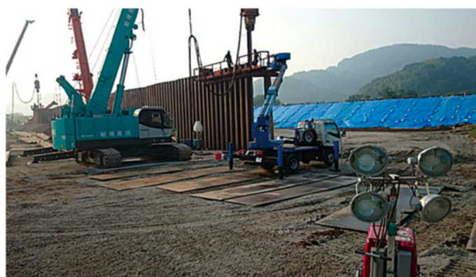
写真 2-5 鋼矢板二重締切堤施工状況
