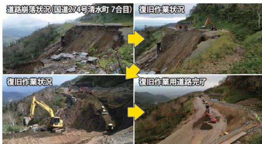
写真 2-4 作業用道路の設置（清水側）
