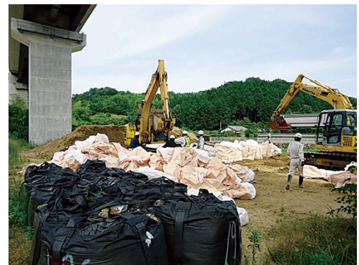
写真 2-11 高梁川高水敷土砂採取状況 写真 2-12 大型土のう製作支援状況 (出典:国土交通省)
