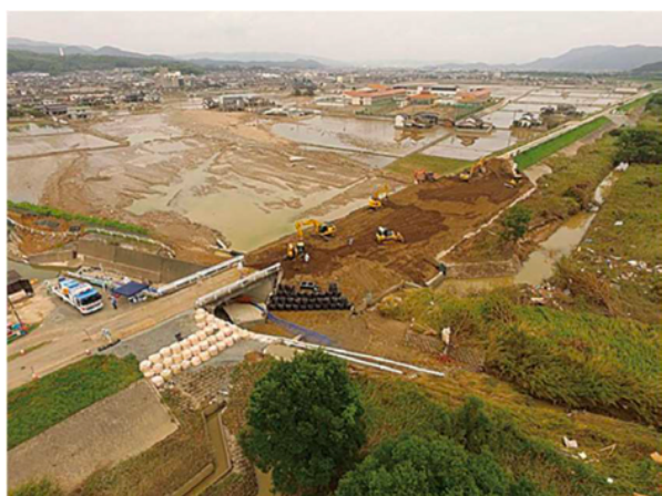
写真 2-3 荒締切施工状況
