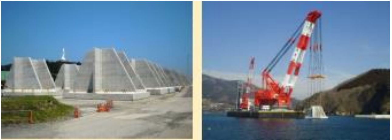
図 2-6 逆 T 型ブロック(左. 製作状況、右. 据付状況) (提供: 東北地方整備局)
