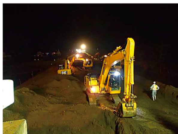
写真 2-4 荒締切盛土夜間施工状況
