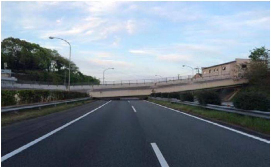
写真 1-10 〈跨道橋の落橋〉九州自動車道府領跨道橋 (出典：西日本高速道路(株))
