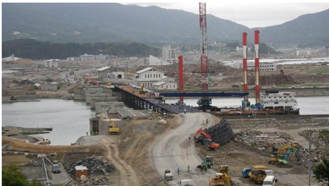
図 2-16 450t 吊クレーン付台船による桁の架設 (仮橋の左側が被災した気仙大橋) (出典：東亜建設工業)
