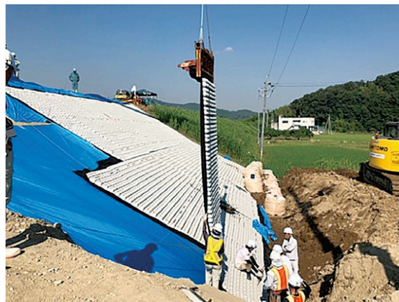
写真 2-13 ブロックマット施工状況 (出典:国土交通省)
