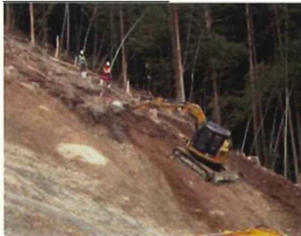
写真 3-9 セーフティークライマー工法 (提供：NEXCO 西日本)
