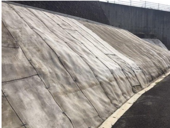
写真 2-14 コンクリートキャンバス施工状況
