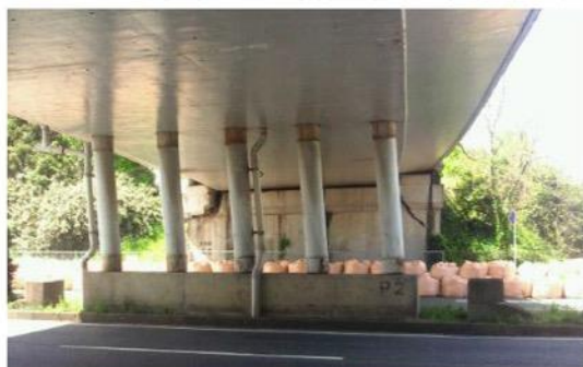
橋脚柱の傾斜
