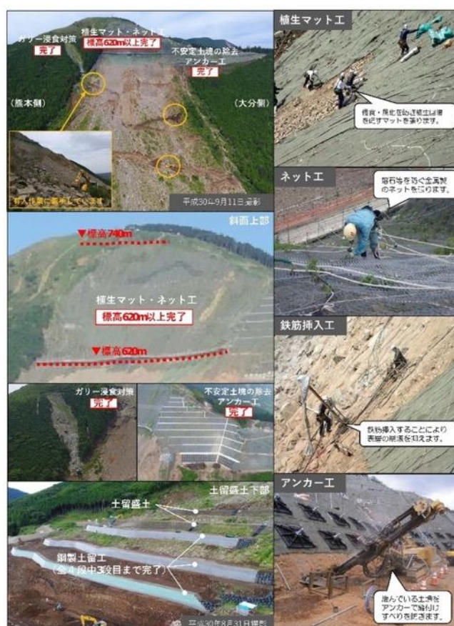
写真 2-5 崩壊斜面の恒久復旧 （出典：九州地方整備局）
