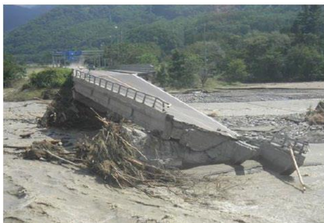
写真 2-1 千呂露橋落橋 （出展：北海道開発局）
