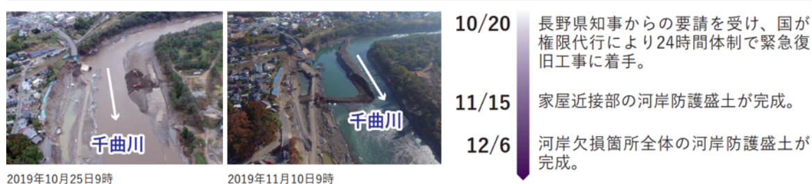
図 2-12 東御市本海野地区の緊急復旧状況
