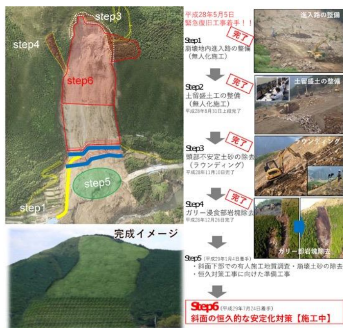
図 2-3 崩壊斜面応急復旧の施工ステップ （出典：九州地方整備局 平成 30 年 9 月）
