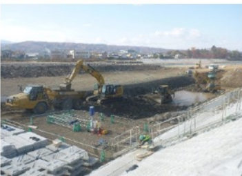
(12) 根固めブロック据付
