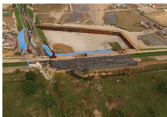
写真 2-6 応急復旧堤防完成状況
