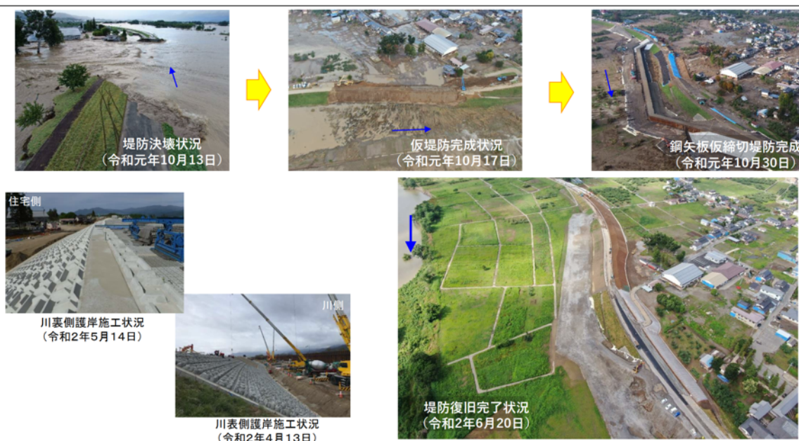
図 2-9 千曲川(長野市穂保地区)の堤防復旧までの流れ (提供：北陸地方整備局)
