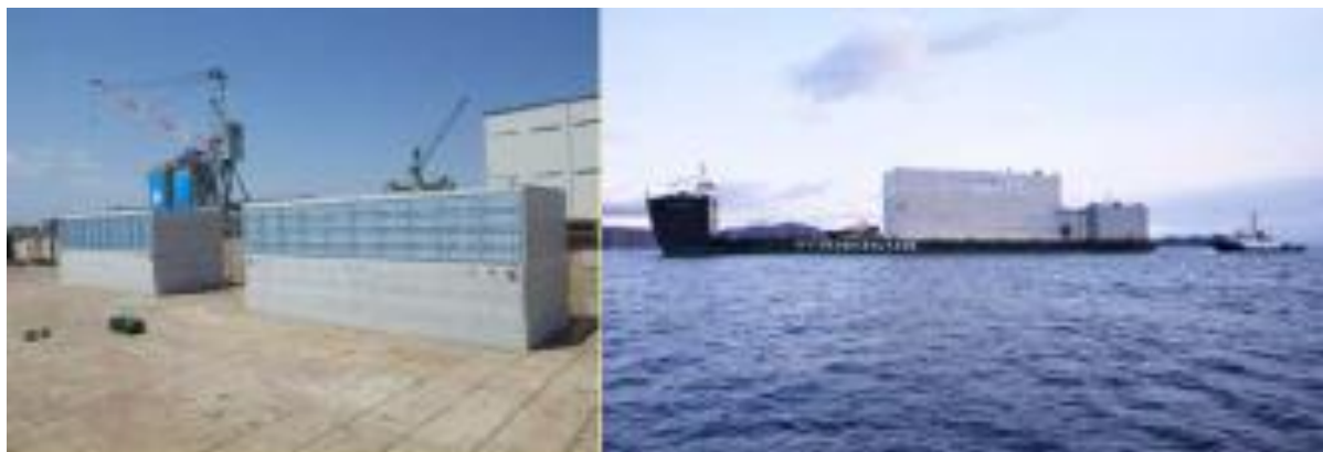
図 2-5 ハイブリッドケーソン（左．完成形、右．入港状況） （提供：東北地方整備局）
