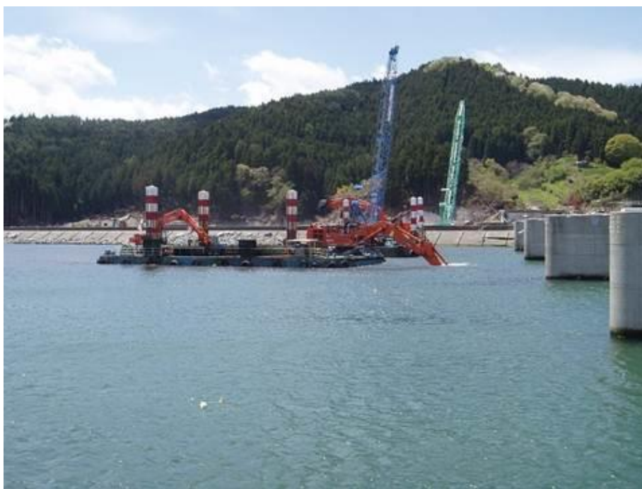
図 2-14 バックホウ台船による川底の浚渫 (出典：東亜建設工業)
