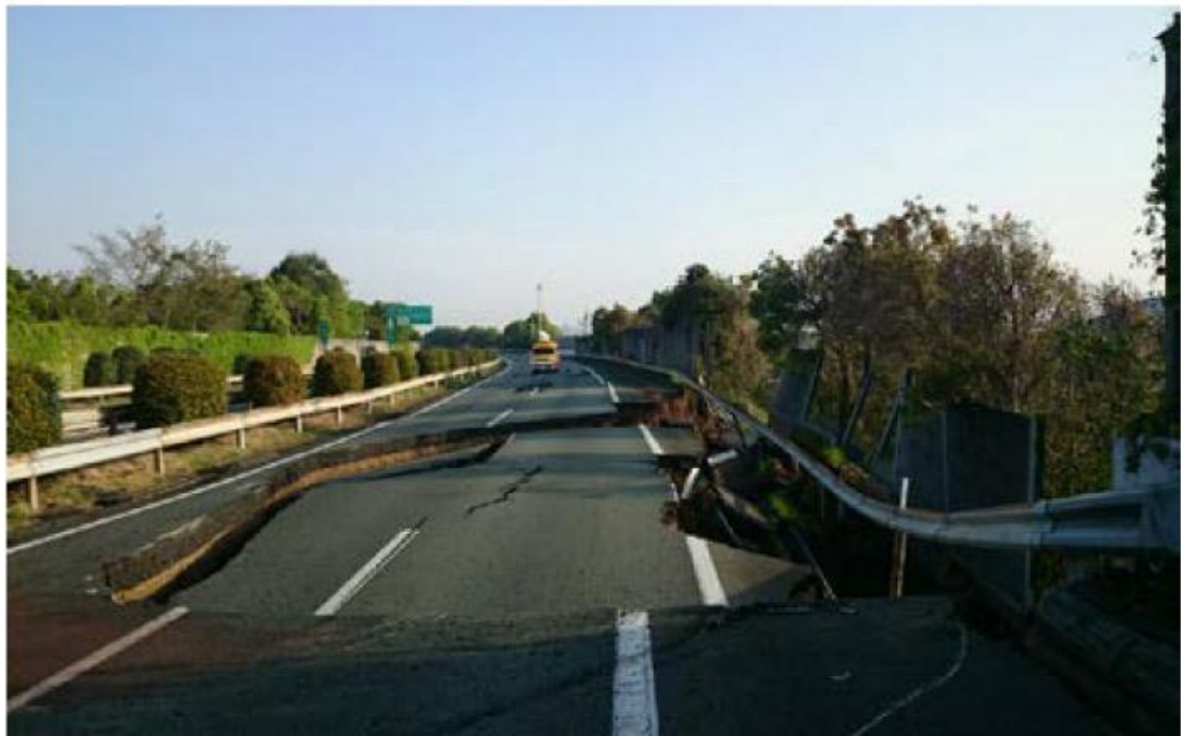
写真 1-8 〈盛土崩壊〉九州自動車道秋津川橋北側 (出典：西日本高速道路(株))
