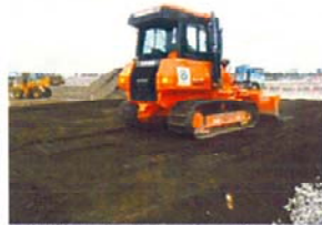
10tブルドーザによる土砂撒出し( 30cm/層)、敷均し
