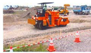
再生砕石による基礎盛土の施工
