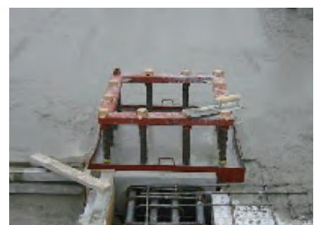
写真-9 梁・床コンクリート打設
