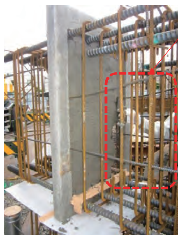
写真-23 ジョインボンド塗布状況
