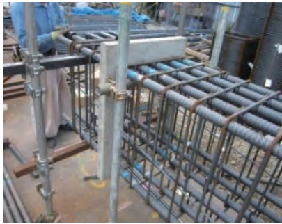
写真-10 仕切り板PCa取付
