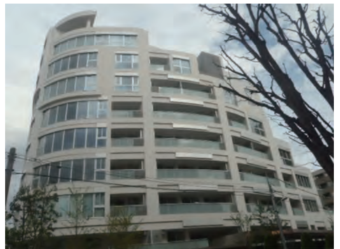
写真-2 全景(東面)
