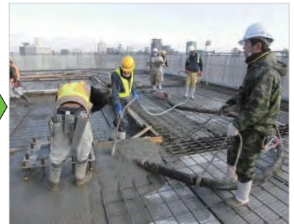
写真-12 コンクリート打設
