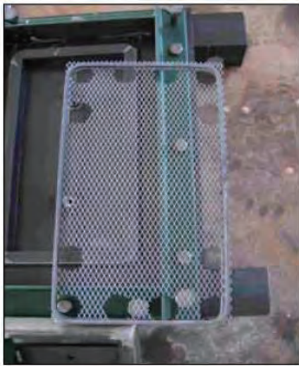
写真-14 仕切り板PCa製作状況その1
