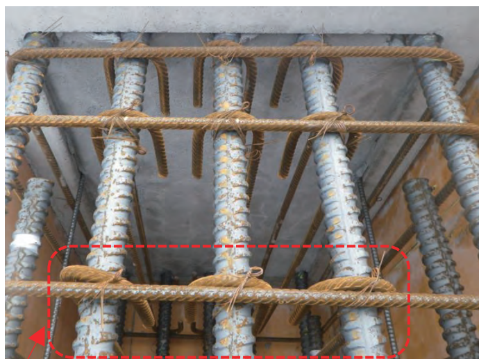
写真-27 コンクリート打設後（後行工区側）
