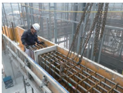
写真-25 梁筋セット
