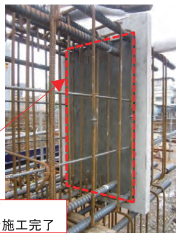
写真-24 ジョインボンド塗布完了
