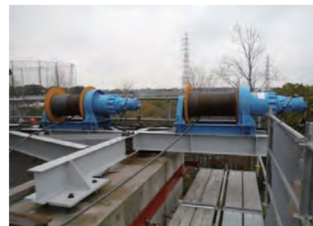
写真1 ウインチ設置状況(X3通側)
