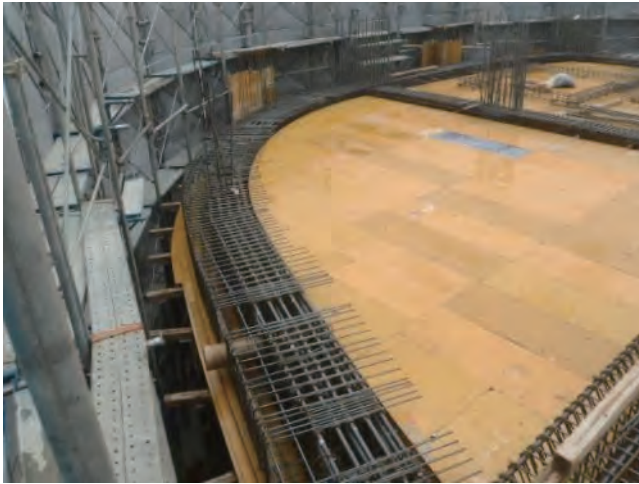
写真-6 アール梁配筋状況
