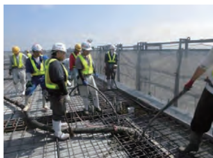
写真-26 コンクリート打設状況
