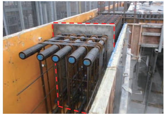
写真-4 仕切り板P C a工法
