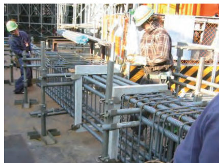
写真-6 仕切り板P C a取付
