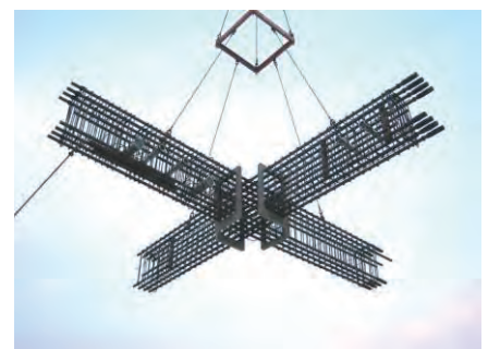
写真-7 先組梁筋ユニット取付
