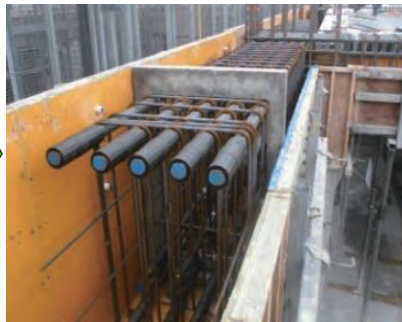
写真-11 梁筋セット
