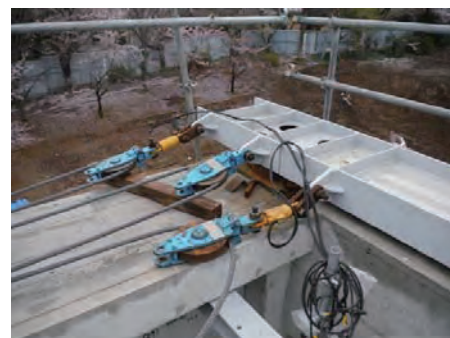
写真2 定滑車設置状況(X13通側)
