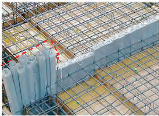
写真-3 スポンジコン止め工法
