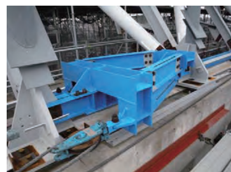
写真3 トラス側動滑車設置状況
