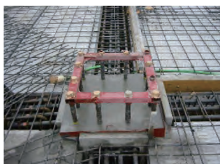
写真-8 柱コンクリート打設
