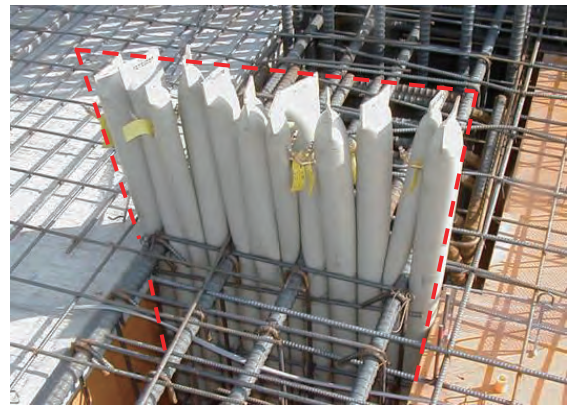
写真-2 エアフェンス工法
