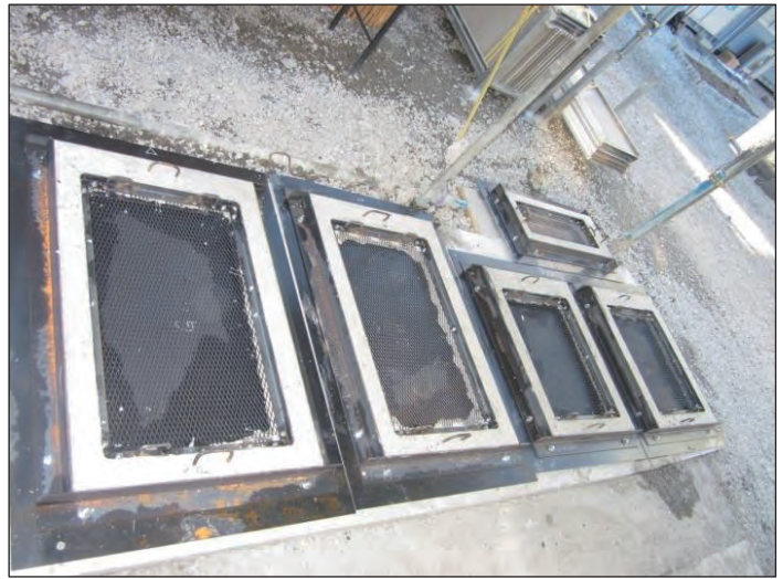
写真-15 仕切り板PCa製作状況その2
