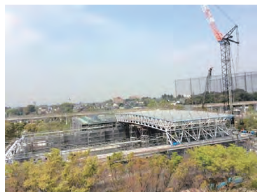
写真7 スライド施工前
