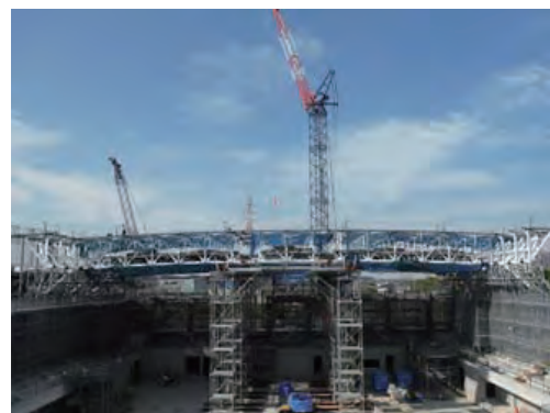
写真6 地組ブロック建方状況
