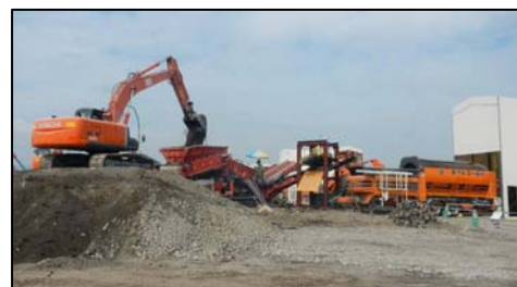
写真-9 津波堆積物の選別状況
