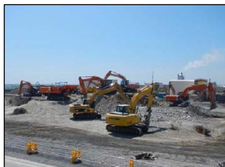
写真-8 コンクリート破碎
