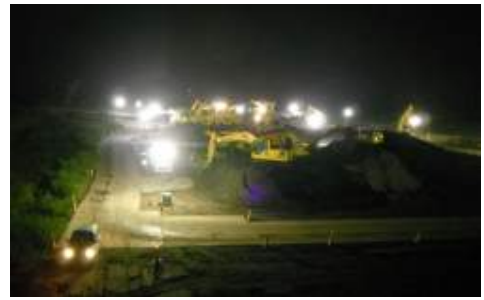
写真-10 夜間作業状況
