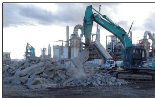
写真-13 コンクリート基礎等の撤去状況
