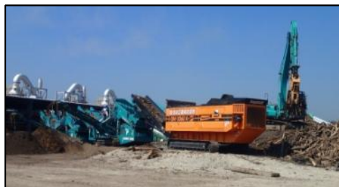
写真-6 木くず破碎状況
