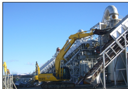
写真-12 焼却炉の解体状況
