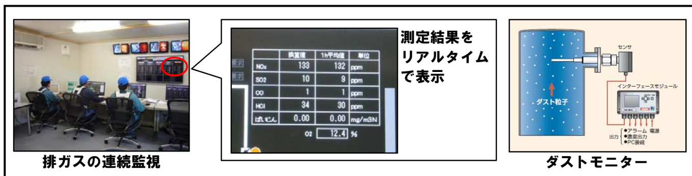
図-11 焼却炉排ガスの連続監視
