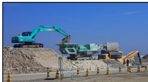
写真-7 コンクリートがら破碎状況
