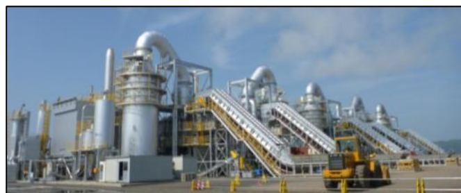
写真-8 焼却施設（全景）
