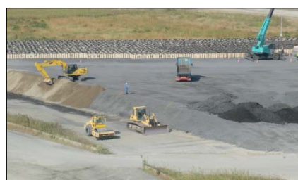
再生資材の盛土状況
