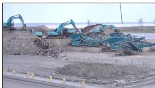
写真-10 津波堆積物の選別処理状況
