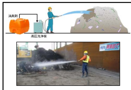
図-10 消臭剤噴霧による対策状況
