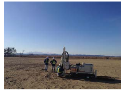
写真-15 復旧時土壤調査状況
