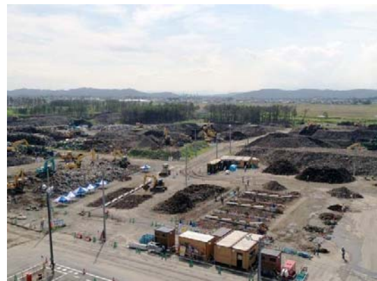
写真-1 二次仮置場の状況（平成 24 年 7 月）
