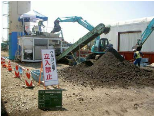
写真-12 造粒固化処理状況
