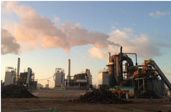
写真-10 稼働中の焼却炉
