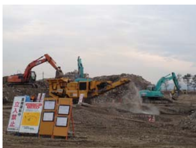
写真-8 移動式破碎機による破碎状況
