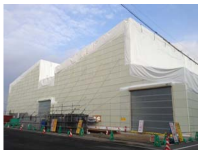
写真-14 隔離養生状況
