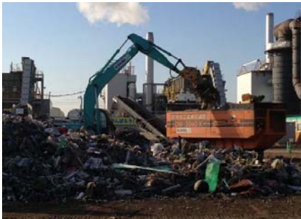
写真-11 可燃物破砕状況
