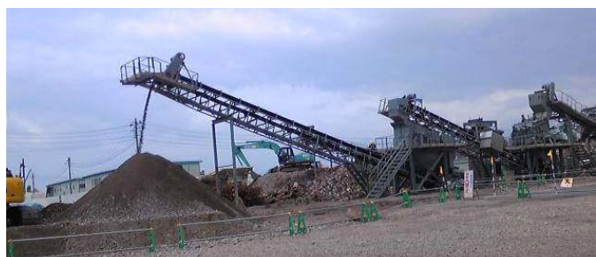
写真-9 固定式破碎機による破碎状況
