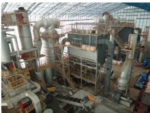
写真-12-3 焼却炉の解体状況(1)
