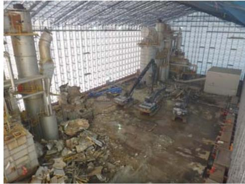
写真-12-4 焼却炉の解体状況(2)
