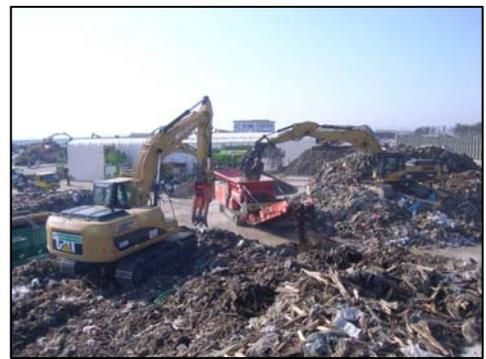
写真-6 混合がれき破砕状況
