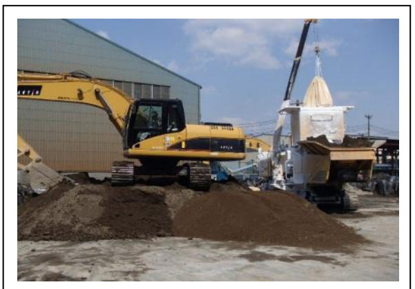
写真-8 選別土砂不溶化状況
