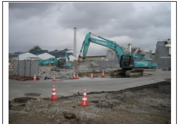
写真-14 復旧作業状況
