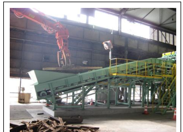
写真-5 木くず破砕状況
