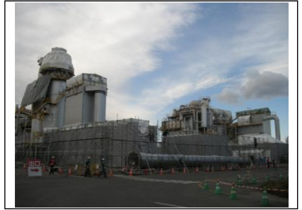
写真-13 焼却炉の解体状況
