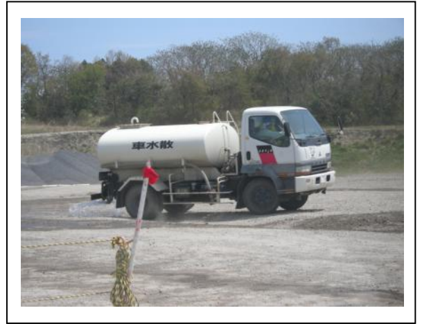
写真-16 散水車使用状況
