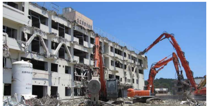
写真-1 RC 建築物解体状況
