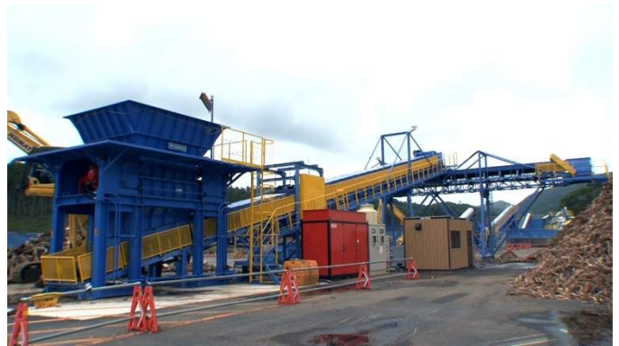
写真-11 木破碎状況
