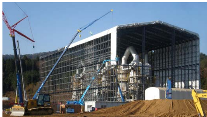
写真-17 焼却炉にテントを設置中の状況
