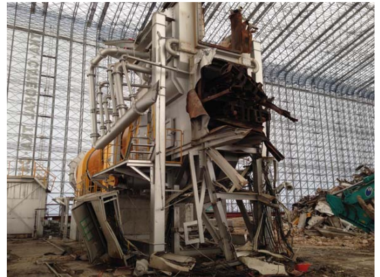
写真-11 焼却炉の解体状況（小泉地区）
