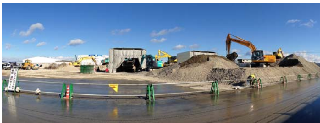
写真-4 コンクリートガラ破碎施設
