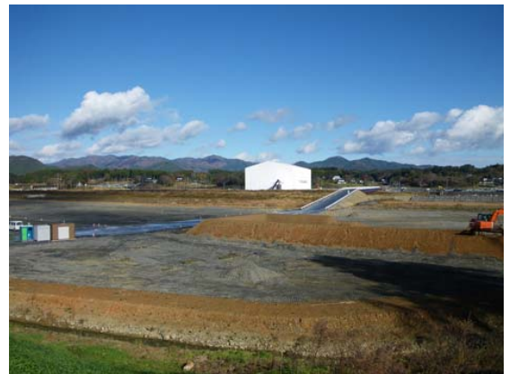
写真-12 復旧作業状況
