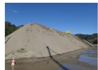
改質土仮置状況
