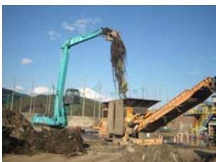
大型破碎機による破碎
