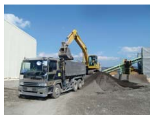
改質土搬出状況
