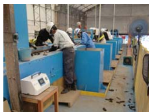
簡易アスベスト計測
