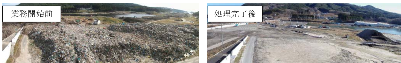
写真-4 業務開始前（左側）と処理完了後の一次仮置場
