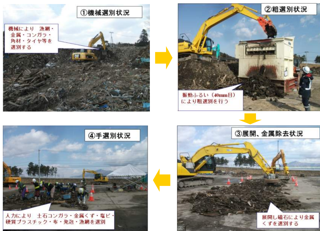
写真-1 一次仮置場での粗選別状況
