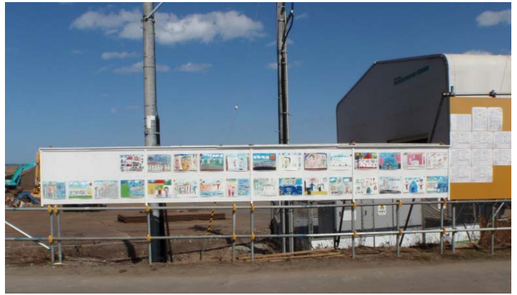
写真-7 地元子供達の絵を現場（二次仮置場）に掲載
