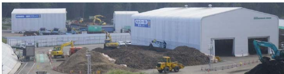
写真-1 二次仮置場全景(米田)
