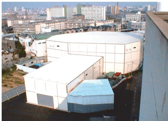
写真-1 工事場所の防塵建屋外観
