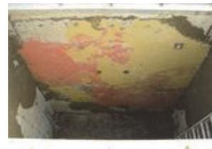
⑥内部土砂掘削後の壁背面注入状況
