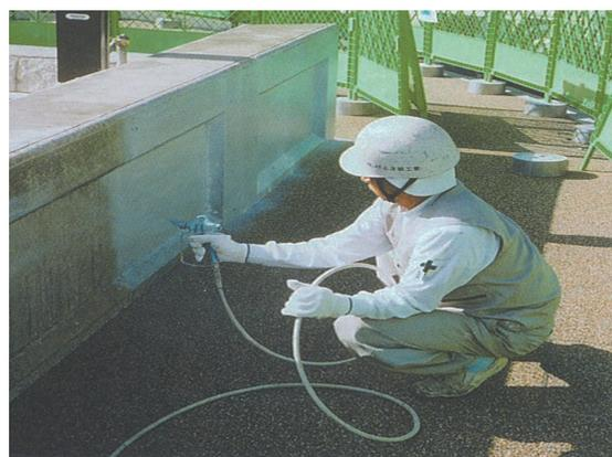
スプレー塗布による施工状況
