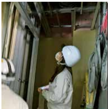
施工現場のPS※内を確認中
