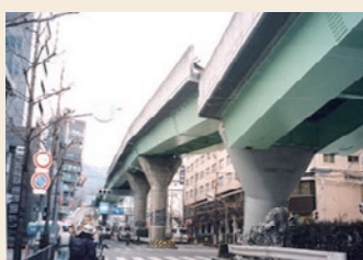
■阪神・淡路大震災における桁落下
