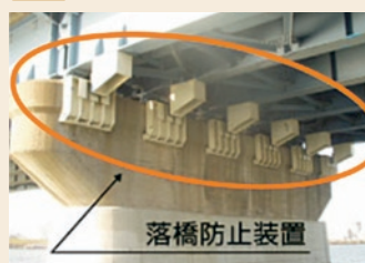
■事例 緊急輸送用道路橋梁の耐震補強
