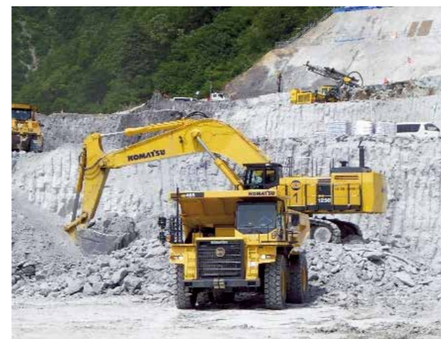
【5.0m 3 級バックホウと 50t 級ダンプトラック】
