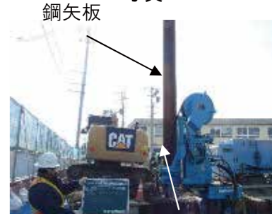
サイレントパイラー
