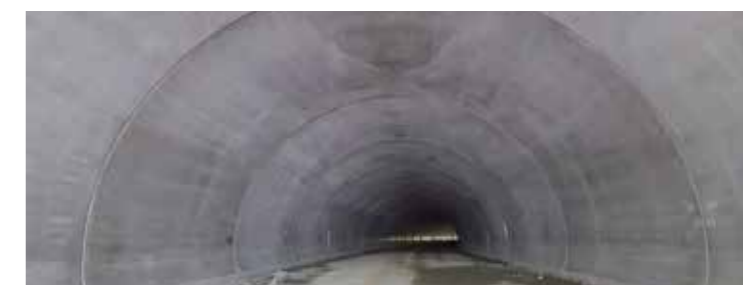
高流動コンクリートによる覆工仕上がり状況
