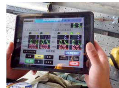
写真-3 移動作業車をタブレットで操作(ジャッキ操作)
