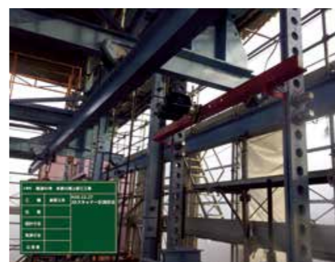
写真-4 3D スキャナーによる小口断面の計測
