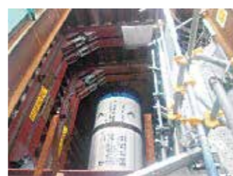
発進立坑内の状況
