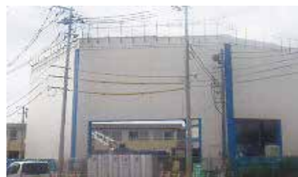
防音ハウス組み立て状況
