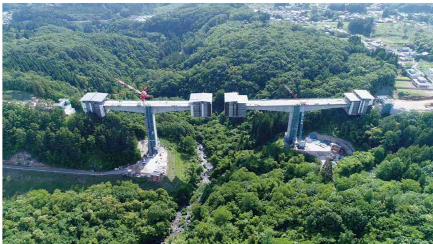
写真-1 (仮称)国道45号 有家川橋
