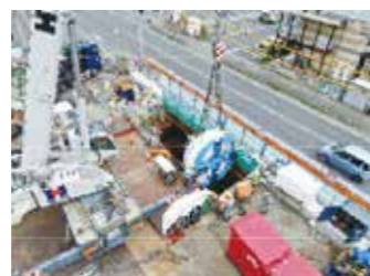
シールドマシン投入状況
