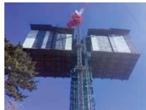
写真-2 採光パネル設置による移動作業車の冬囲い
