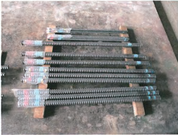
写真 2.1 試験体製作状況（鉄筋、塗装あり）
