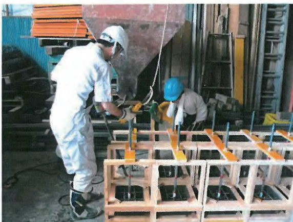
写真 2.5 試験体製作状況（コンクリート打設）
