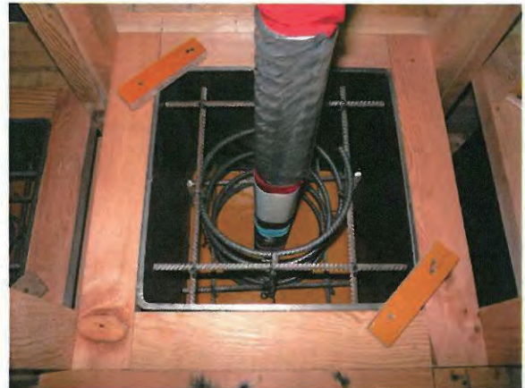
写真 2.4 試験体製作状況（配筋、D41）
