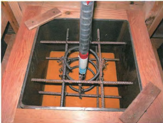
写真 2.3 試験体製作状況（配筋、D19）
