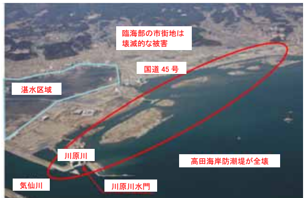
図 5.4.9 被災後の状況(陸前高田市) 48)
