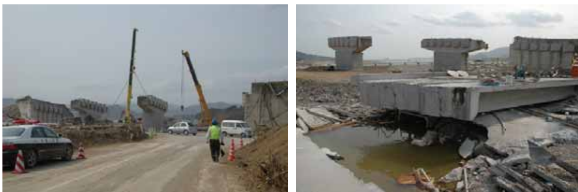
図 5. 5. 41 沼田跨線橋の全景および流失した P C 桁 57)
