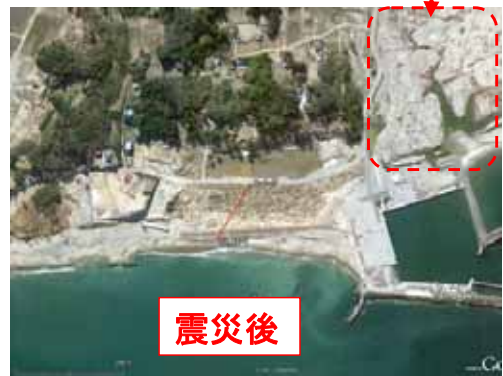
図 5.5.80 山元町磯浜地区における被災状況 66)
