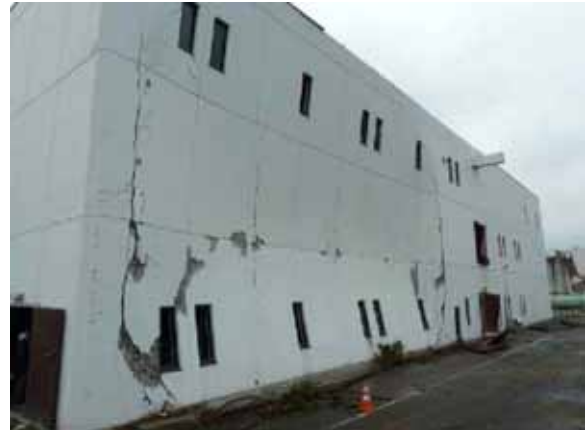
図 5.5.54 壁の面外破壊 58) (宮城野区蒲生、1階建) 浸水深 9m
