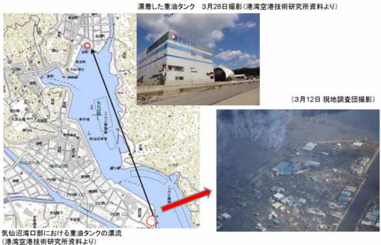
図 5.5.67 貯蔵タンク被災事例（気仙沼港） 63)
