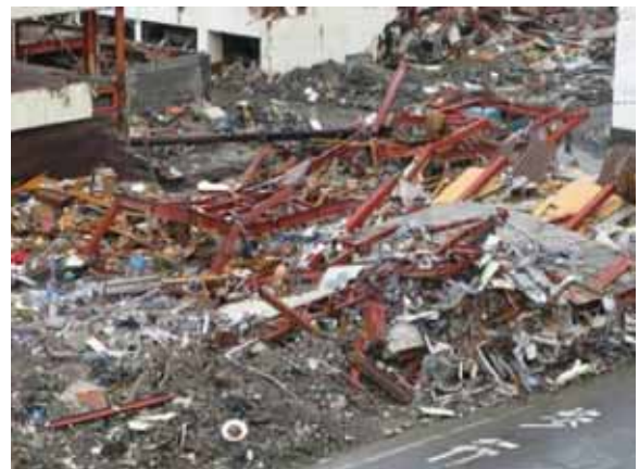
図 5.5.58 倒壊 58) (女川町、2階建) 浸水深 15m 程度
