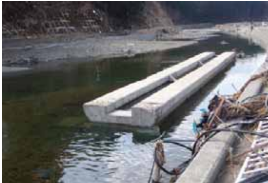
図 5.5.44 中央径間にあった P C 桁 57)
