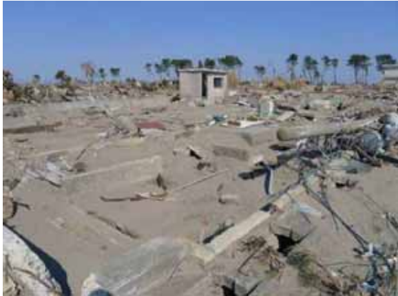
図 5.5.59 上部構造, 土台とも流失 58) 浸水深 4m 超
