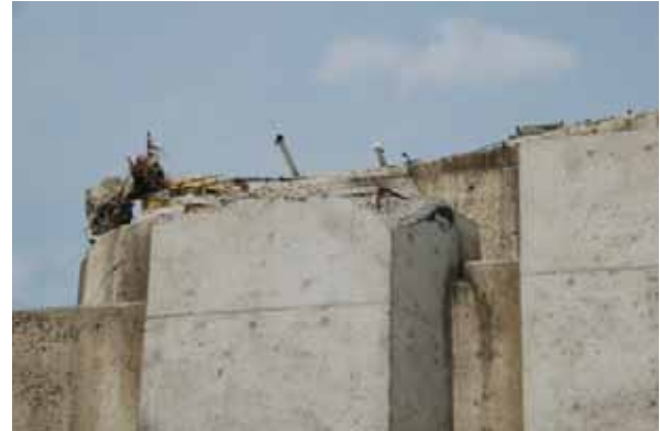
図 5.5.42 損傷した橋台頂部と橋脚の頂部 57)
