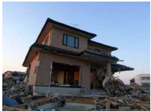
図 5.5.62 べた基礎ごと流下移動 58) (名取市、2階建)
