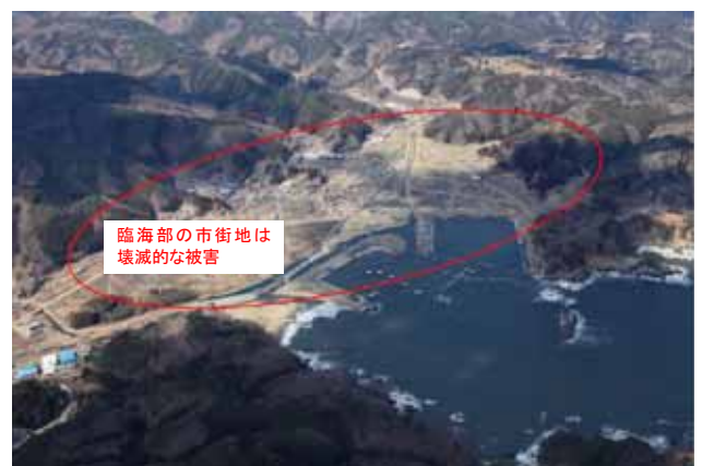
図 5.4.3 被災後の状況（宮古市田老地区） 48)
