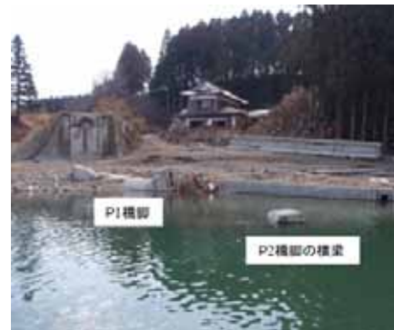
図 5.5.43 倒壊した 2 つの橋脚 57)
