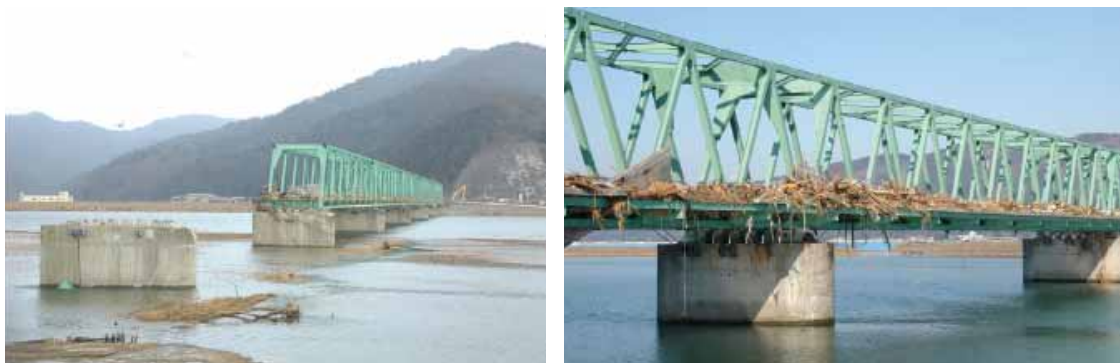
図 5.5.34 新北上大橋の被害状況 (全景) 57)
