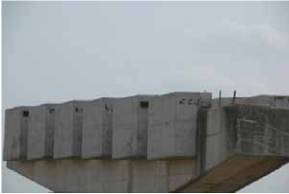
図 5.5.42 損傷した橋台頂部と橋脚の頂部 57)
