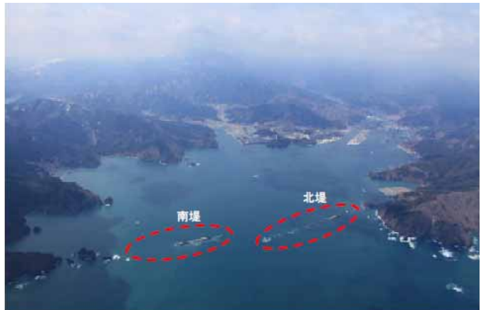
図 5.4.6 被災後の状況（釜石市） 48)
