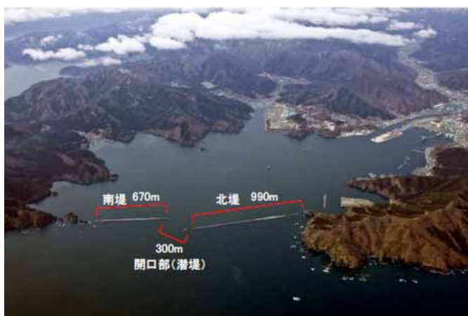
図 5.4.5 被災前の状況 (釜石市) 48)
