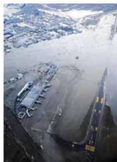
図 5.5.17 津波で浸水した状況 53)
