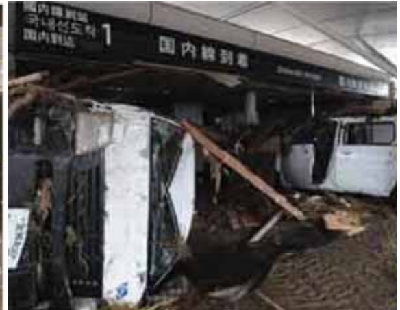
図 5.5.20 建物内の漂流物状況 53)
