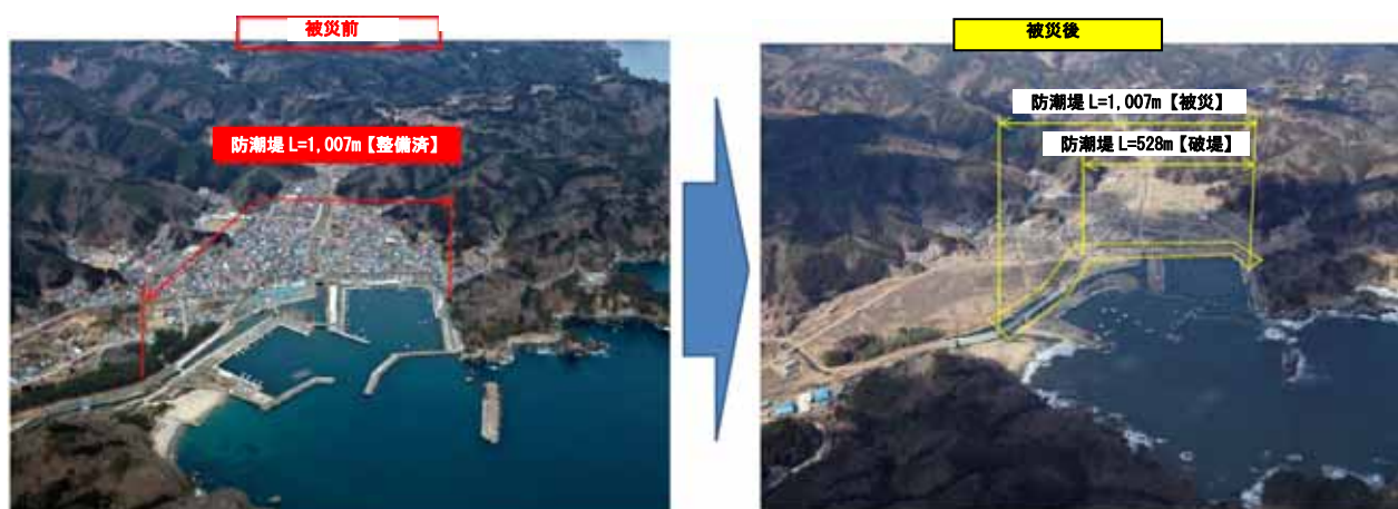
図 5.5.68 漁港の被災事例 (田老漁港) 65)
