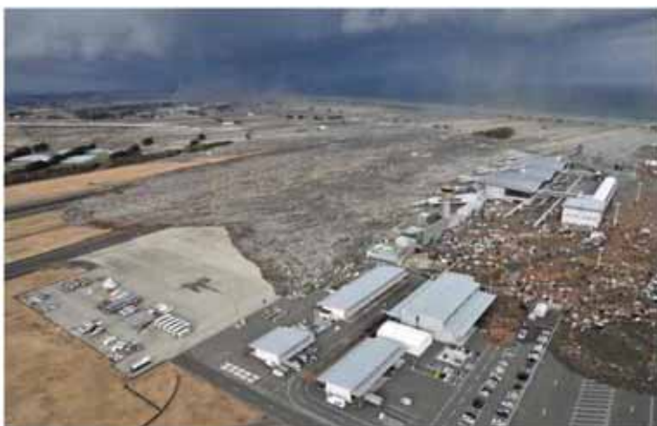
図 5.5.16 津波で浸水した状況 53)
