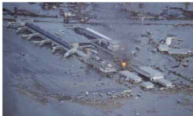
図 5.5.15 空港ターミナルビル浸水状況 53)
