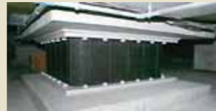
国内最大級となる、1.6m角の巨大な角型免震装置
