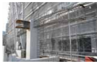
サイトPCヤードの作業も終盤を迎えている
