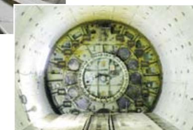
凍結工法を採用しているこの現場には、さらなる未知の世界が。雨水の浸入や地山の崩壊を防ぐために、マイナス30度で凍らせた壁の体験が可能でした。後に掘削する部分だけ完全に凍結しないよう温水管で温めるなど、新たな発見も。これは強力なメニュー!
