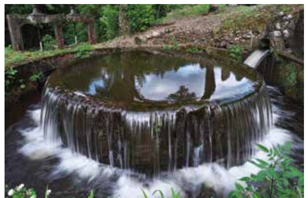
富山県内には5基の円筒分水槽があるが、そのどれもが個性的な存在感を放っている。南砺市の赤祖父円筒分水槽も国の登録有形文化財に登録されている。農業土木の一端を現役に担っている貴重な土木遺産だ。
