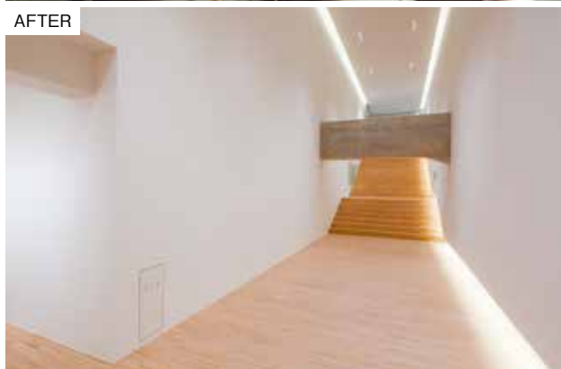
1階ギャラリーから地下1階に下りるエリアの施工中(上)と完成後(下)の様子。既存躯体をあえて残し、館内にプロムナードを構築。美術館を回遊しながら作品を見学することができる(提供：TOSHIHIRO MIZUTANI ARCHITECTS)
