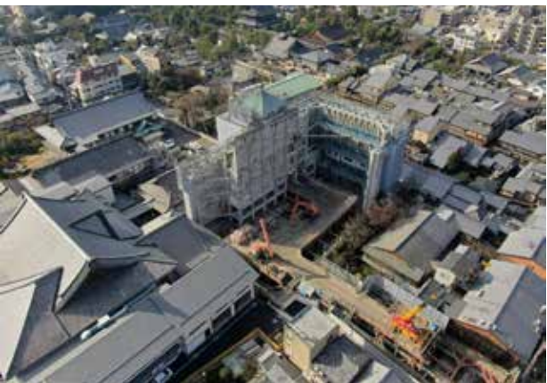
新築する北棟には由緒あるお茶屋が隣接する。土留めにより植栽の根を傷つける懸念があったため、慎重に施工した。「翌年には隣のお茶屋さんのモミジが例年と変わらず美しく紅葉してくれた。ホッとしました」と松本氏は話す
