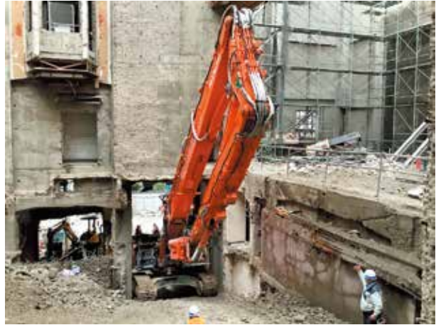
21mのロングアーム重機を最小限解体したファサードから撤入し本棟部を解体、保存する外壁は仮設鉄骨で補強していく。その都度構造の健全性を精緻に確認した
