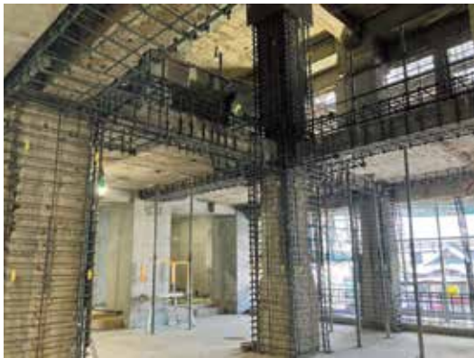
既存躯体の保存補強の状況
