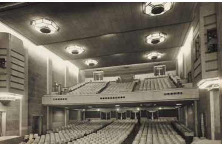
1936年に竣工した弥栄会館の外観(右)と劇場(左)
