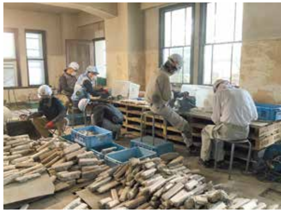
設計では外装のタイルを10%再利用することが決められていた。「細心の注意を払いながら16,000枚余りを『生け捕り』にしました。脆くなったタイルの剥離、保管は専門技能者のプライドをかけた仕事でした」(芝田氏)
