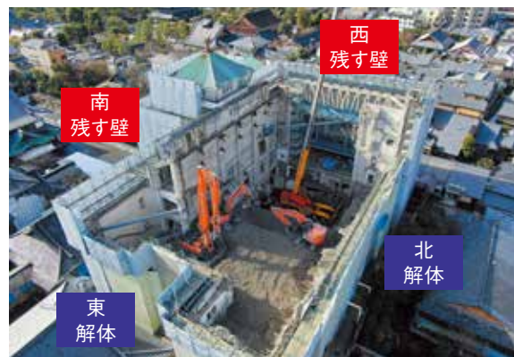
南面・西面の外壁と構造体を残しながら増改築を行う
