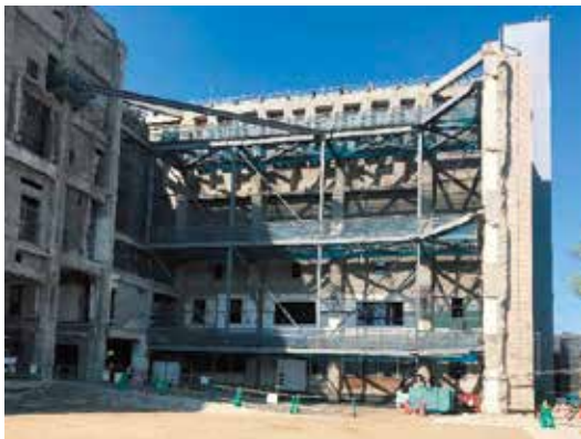
一次解体(地上)完了状況
