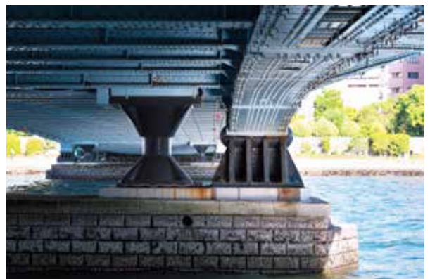
建設当時、日本最大の支間を誇った永代橋の基礎部は、地上でコンクリート製の躯体を構築しながらこれを沈下させるニューマチックケーソン工法によって築かれた。日本初となるこの潜函工法は同じく重要文化財に指定された清洲橋でも採用されている。その雄姿とともに技術的要素も含め貴重な現役インフラは今もその使命を果たしている。
