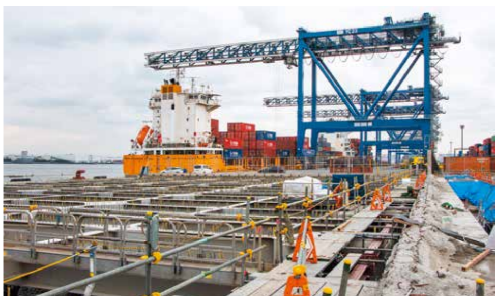
上/Y3バースにて、鋼管杭打設が行われている状況(取材4月末時点) 下/供用中のY2バース(写真奥)に接続するY3バースA工区には既に2基のジャケットが4月までに据え付けられた。五洋建設はこのA工区の施工にも携わっている。吉田所長は「現在進捗するB工区の4基の据付にもA工区を担ったプロフェッショナルたちが参集してくれました。施工の練度は確実に高まっています」と協力会社、スタッフに全幅の信頼を寄せている
