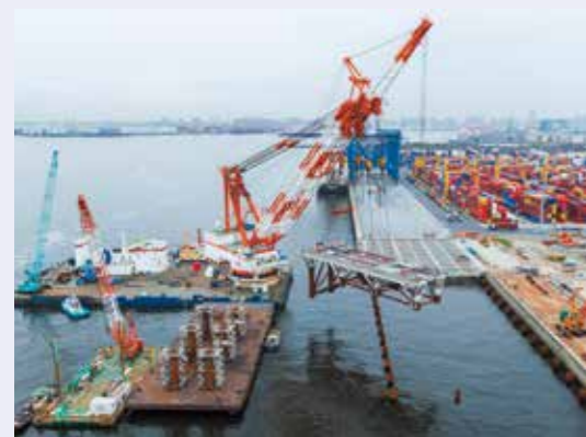
ジャケット据付状況
