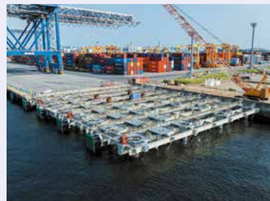
ジャケット据付完了
