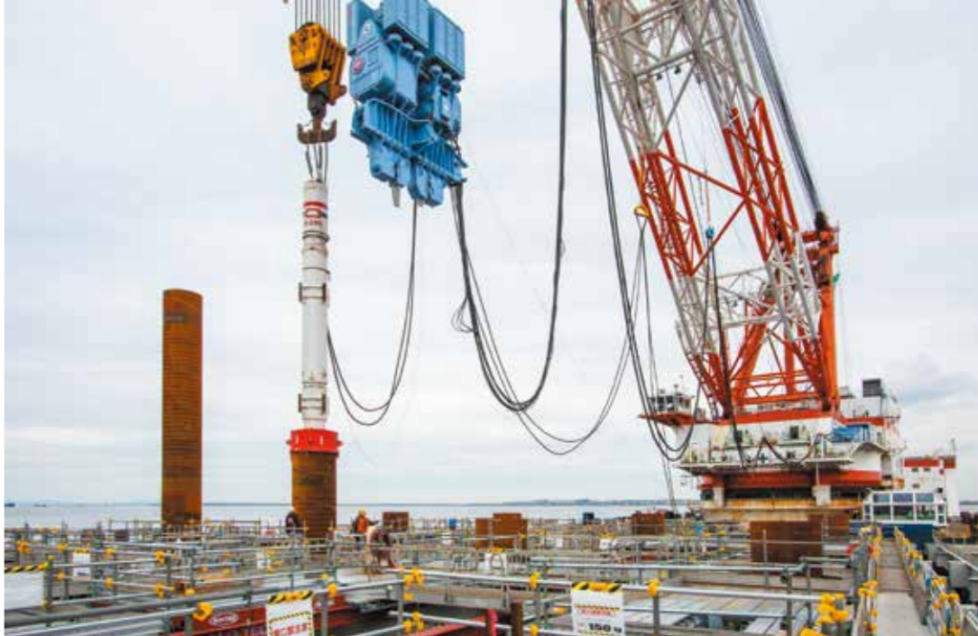
上/Y3バースにて、鋼管杭打設が行われている状況(取材4月末時点) 下/供用中のY2バース(写真奥)に接続するY3バースA工区には既に2基のジャケットが4月までに据え付けられた。五洋建設はこのA工区の施工にも携わっている。吉田所長は「現在進捗するB工区の4基の据付にもA工区を担ったプロフェッショナルたちが参集してくれました。施工の練度は確実に高まっています」と協力会社、スタッフに全幅の信頼を寄せている
