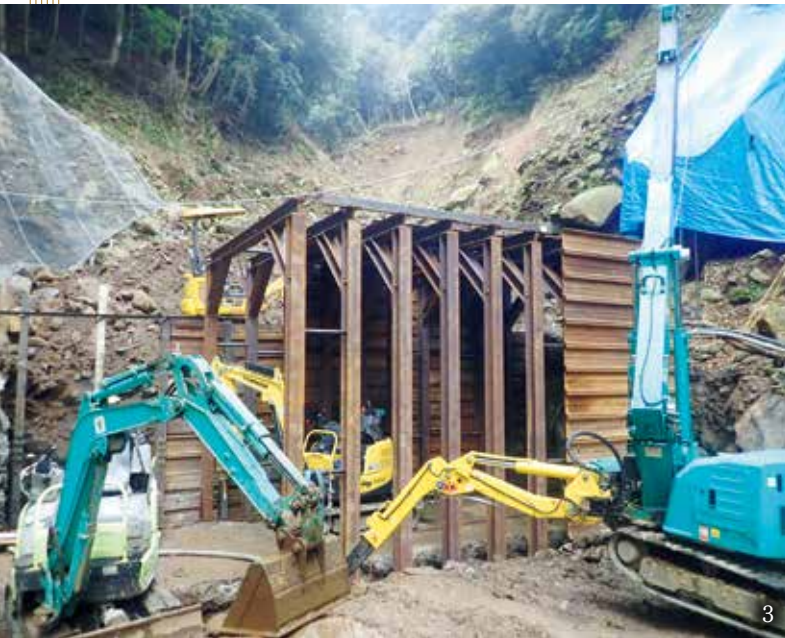
1. 導水路 落盤部の崩壊状況 2. 導水路レジンパネルなど仕上げ完了時 3. 導水路損壊部作業時の鋼製支保工による防護壁 4. 白川発電所新設建屋
