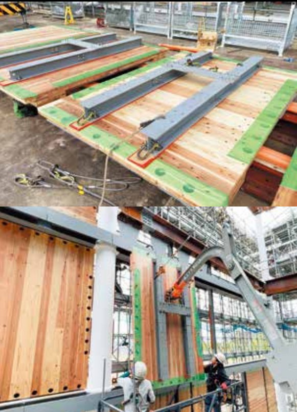
右／CLTを鉄骨で挟み込む形でブレースのように機能させている 左上・左下／木造耐震壁となるCLTの据付の際は、「ランサー」を使用した（提供：鉄建建設(株)）
