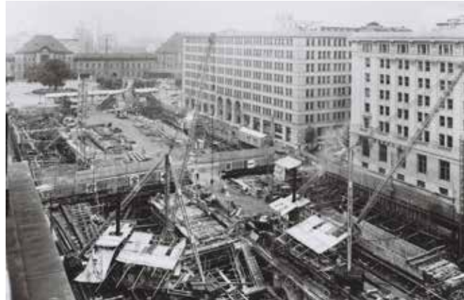
1960年に開業した丸の内駐車場の建設状況。街にあふれる車を収容する場所を確保するため、行幸通りを掘り起こして地下2階520台収容できる地下駐車場が設けられた(提供：三菱地所)
