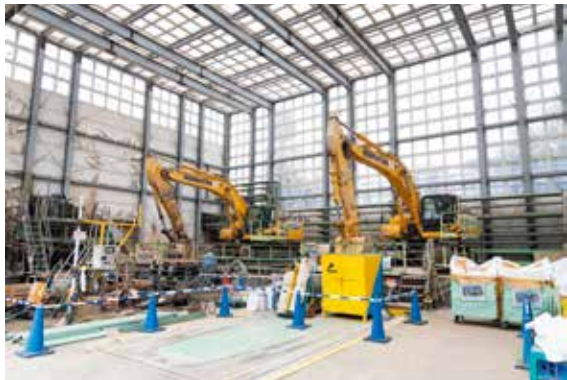
右／近隣の民家に配慮し日光を遮らないように天井・壁面にガラスを使用して建てられた防音ハウス 左／シールドの切羽部 (いずれも撮影：中原一隆)
