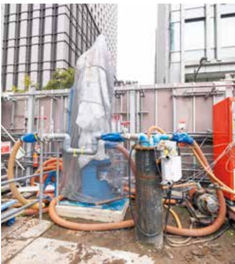
右／複雑に入り組む埋設管を吊り防護しその機能を維持したまま施工を行う 左／施工中における地下水対策用の設備。地下およそ30m地点の水を吸い上げて施工エリアを乾いた状態に保ちつつ、吸い上げた水は地下100m以上にある複数力所の井戸に戻すことで周辺地域の水の流れに大きな影響が出ないように計画されている
