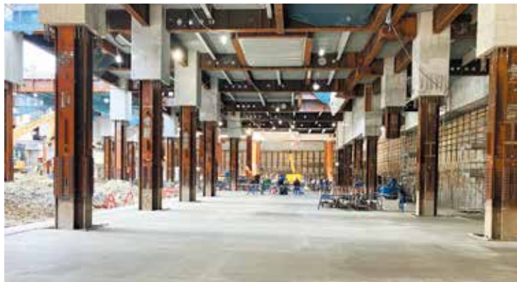
上／既存躯体を補強し山留として活用することで周辺インフラへの影響の抑制や施工エリアの確保を可能にしている 下／地下1階から下階に向かって新しい躯体を構築していく(9月初旬現在) (いずれも提供：鹿島建設株)
