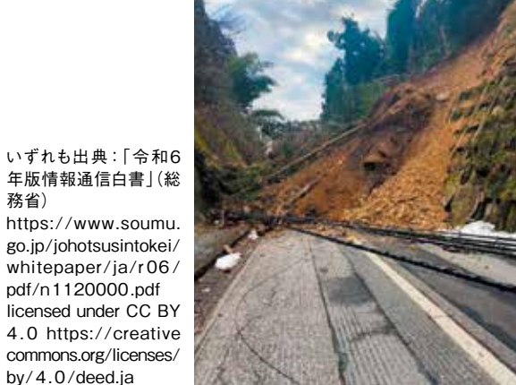
土砂崩れにより損傷した伝送路（石川県輪島市）
