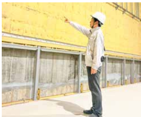
スタジオ壁面の施工状況確認
